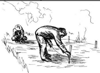
Fig. 26 – Marcação da obra
